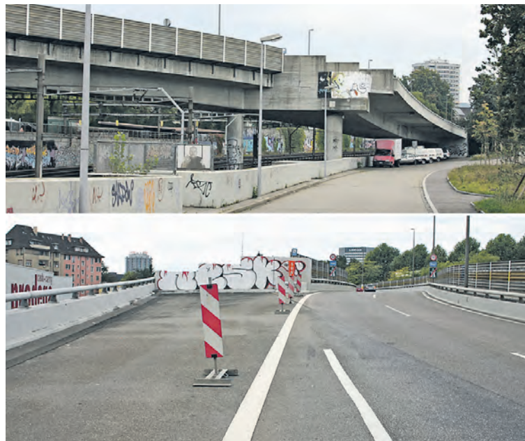
«Unser Erinnerungsdenkmal»: Die Bauruine als Zeugnis einer Gundeli-Umfahrungsvariante, die zwar geplant und versprochen, aber nie realisiert wurde! Der schräg in der Landschaft stehende «Betonstümpe» bei der Autobahnausfahrt Wolf wurde eben zum unübersehbaren Denkmal für niemals realisierte «Gundeli-Visionen».
