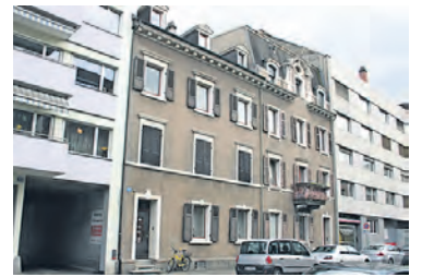
Die Gebäude an der Sempacherstrasse 51 und 53 werden ebenfalls abgerissen. Foto: GZ.
